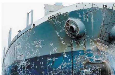
錆は海難事故の大きな原因となっている
